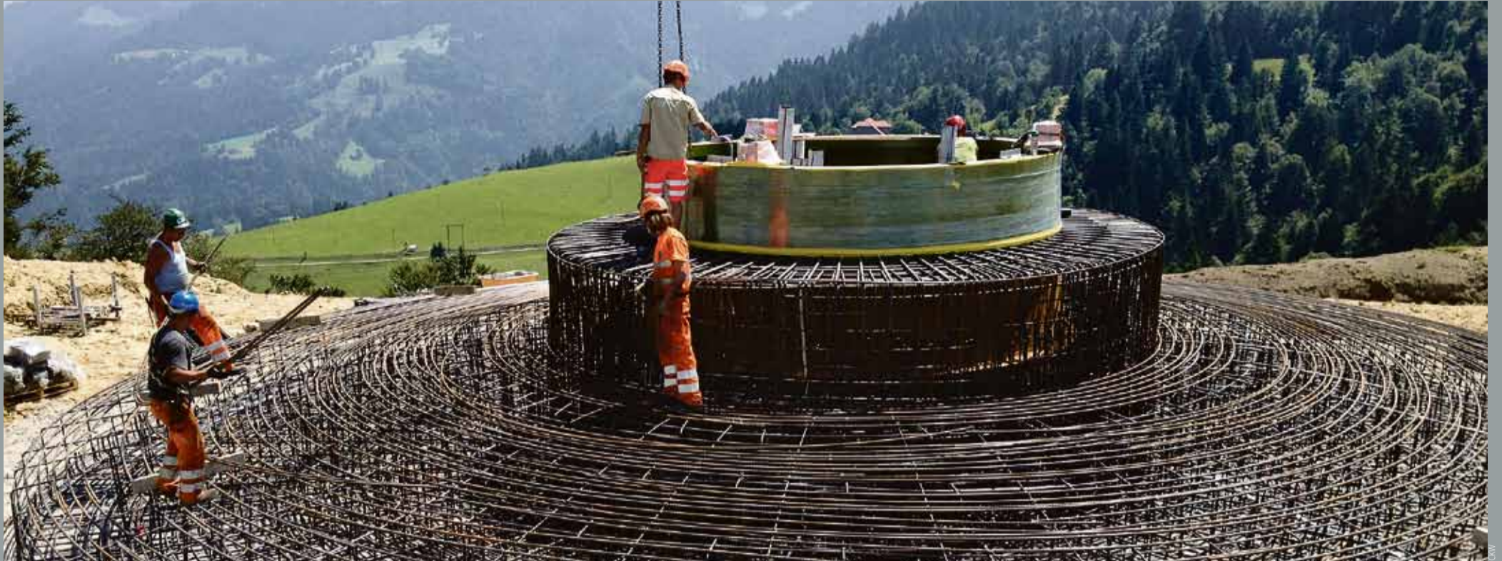
Fundament: Dieses hat ein Gewicht von 700 Tonnen. Das Windkraftwerk allein ist 350 Tonnen schwer, damit ähnlich schwer wie zwei grosse Passagierflugzeuge. Gebaut wurde die Anlage auf 1100 Metern über Meer.
