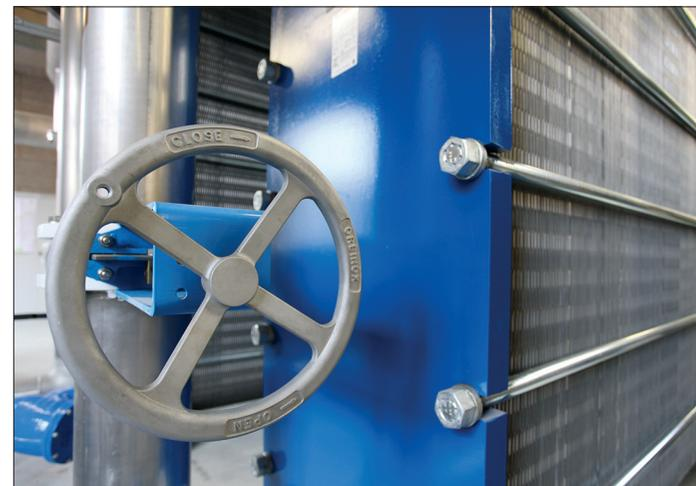
Handschieber am Wärmetauscher in der Wärmezentrale der «Wärme Frauenfeld AG»
