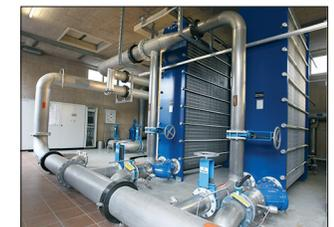
*Wärmegewinnung in Wärmetauschern*
